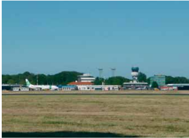
Baanverlenging en uitbreiding
